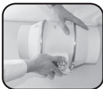
4. Zamocować moduł silnika do podstawy urządzenia
